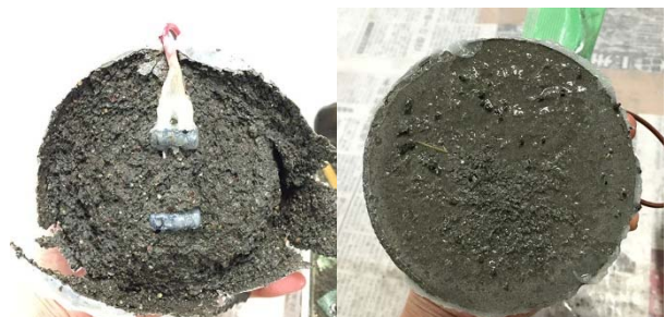
(a) セメントモルタルの断面欠損
