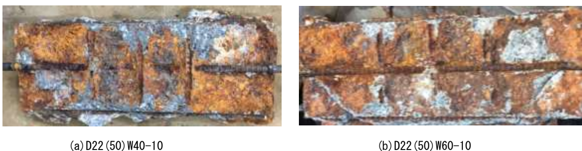
写真-3 D22(50)W40-10 および D22(50)W60-10 の剥落片側
