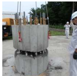
写真 - 15 杭余盛り部の 揚重 (試験体 2)
