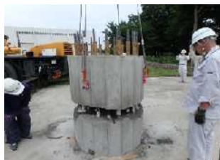
写真 - 21 杭余盛り部の 揚重 (試験体 3)
