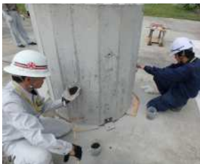
写真 - 25 タンピング (試験体 4)
