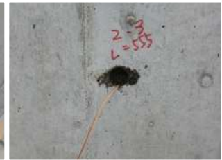
写真-6 装薬・充填 完了（試験体1）
