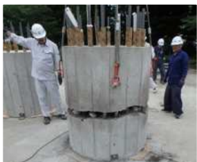
写真-9 杭余盛り部の 揚重（試験体1）
