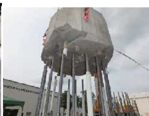
写真 - 28 杭余盛り部の揚重 (試験体 4)
