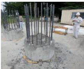
写真 - 27 破断面の状態 (試験体 4)
