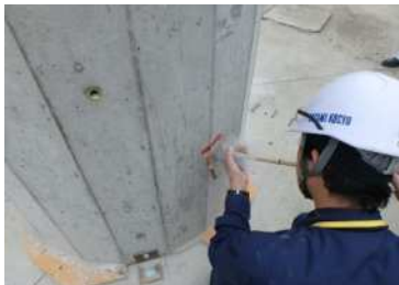
写真 - 13 タンピング (試験体 2)
