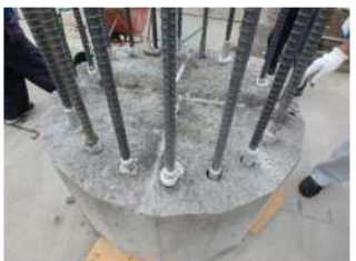
写真-10 破断面の状態 （試験体1）
