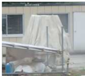
写真-7 防爆養生 （試験体1）
