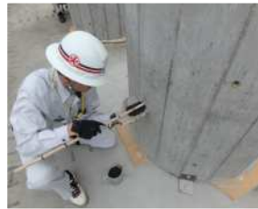
写真-5 タンピング （試験体1）
