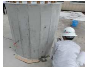
写真 - 19 タンピング (試験体 3)
