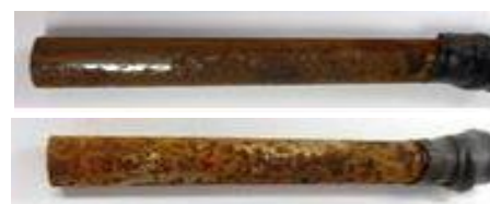
写真-1 腐食程度 上：グレードⅡ 下：グレードⅢ
