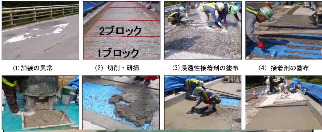
(1) 舗装の異常 (2) 切削・研掃 (3) 浸透性接着剤の塗布 (4) 接着剤の塗布
