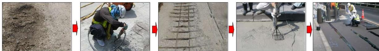
(1) 土砂化 (2) ブレーカによる削り (3) 土砂化の除去 (4) 補修 (5) 橋面防水
