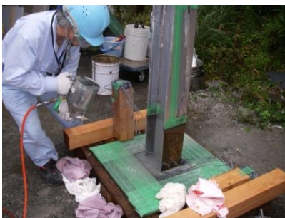
(a) PCM 吹付施工状況
