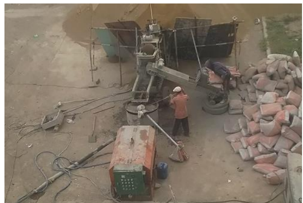
写真-2 建設現場における練混ぜ作業
