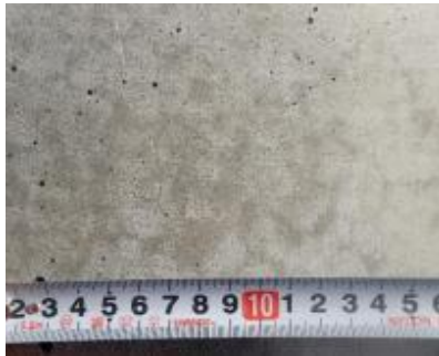
写真-3 水噴霧時に確認できるマイクロクラック
