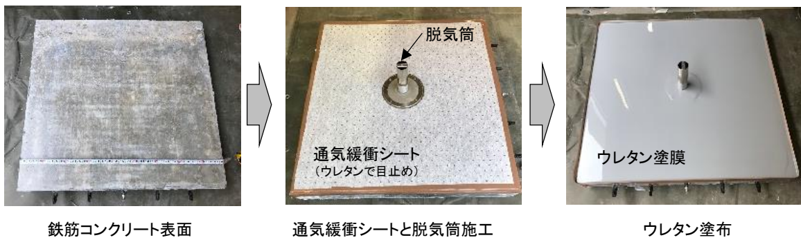
写真-1 絶縁仕様でのウレタン塗膜過程
