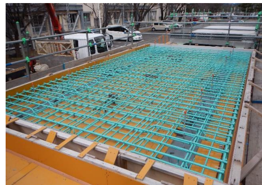
写真-1 配筋状況
