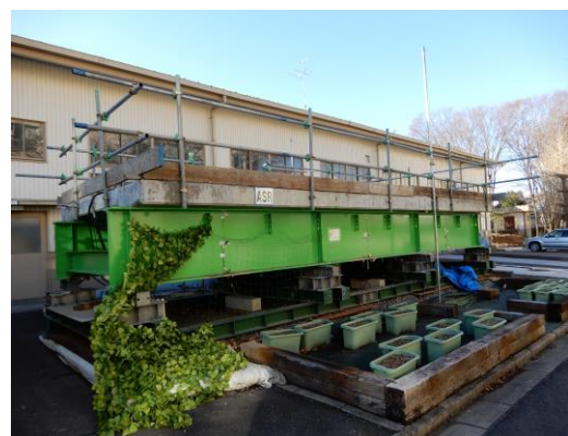
写真-2 本橋の全景
