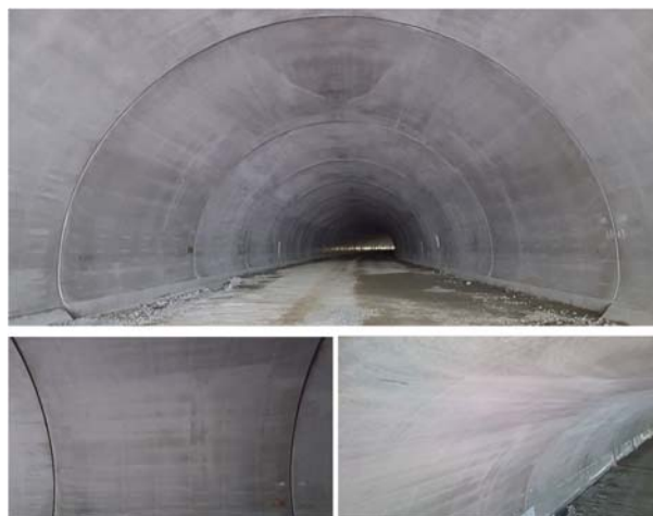
写真-3 新規の高流動コンクリートで構築した覆工
