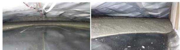
写真-2 高流動コンクリートの流動状況 (天端部)
