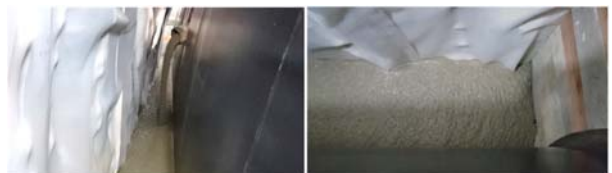
写真-1 高流動コンクリートの流動状況 (側壁部)
