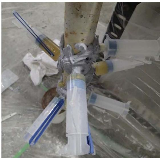
図-6 補修材注入状況
