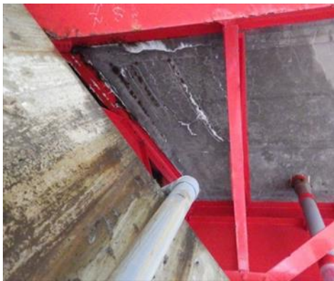
写真-1 床版下面 パネル 1-6 桁端部の状況
