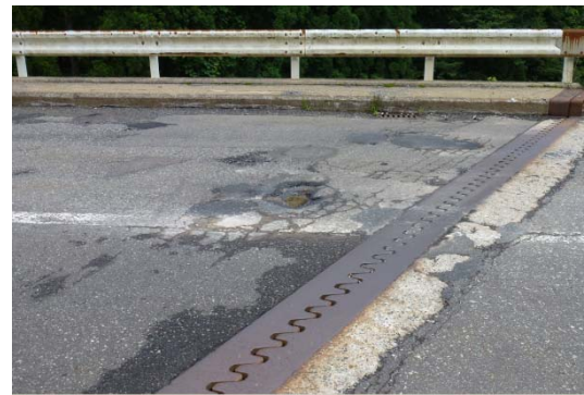
(a) ジョイント近傍の舗装面
