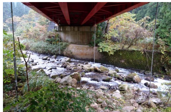
(b) 主桁変位(床版変位計測で固定している不動梁からスチール製の伸縮棒を垂らして主桁変位を計測)
