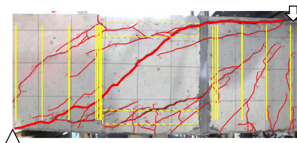
図-6 No.4 の最大荷重時のひび割れ性状
