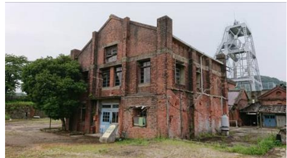
写真-1 実地調査した歴史的建造物（万田坑事務棟）
