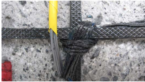
写真-1 CFG板格点結束部
