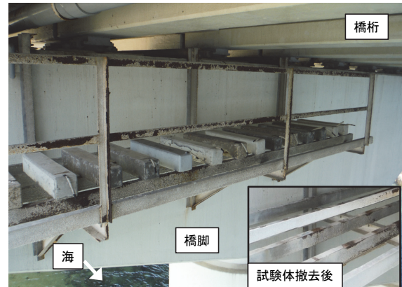
写真-1 試験体暴露架台
