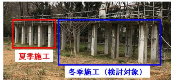
写真-1 中規模 RC ラーメン模擬高架橋
