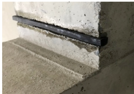
写真-2 止水材の取り付け状況
