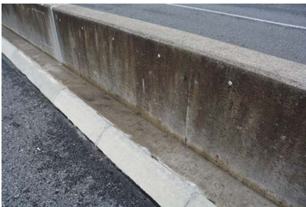
写真-1 コンクリート製壁高欄
