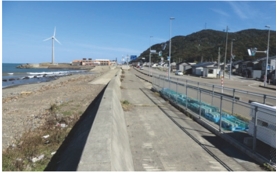
(a) 新潟の曝露試験場（海岸より、0.1km 付近）
