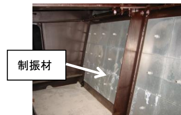
(b) 橋梁箱桁内ウェブに設置された制振材の例
