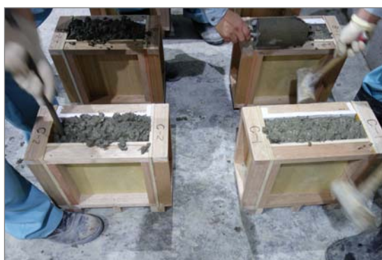
写真-2 コンクリートの打込み・締固め状況
