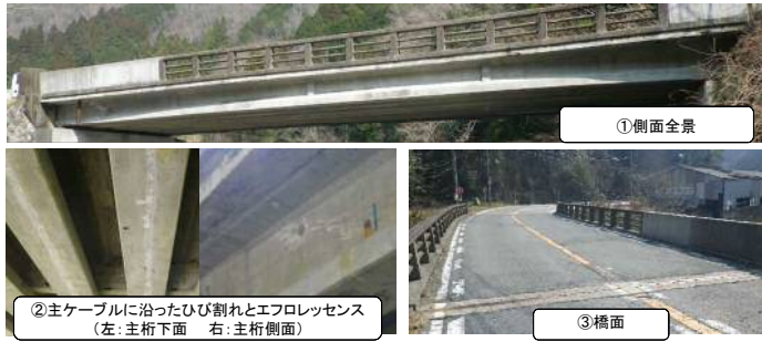
図-1 M橋の外観（補修前）
