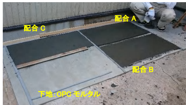
図-8 屋外施工時の左官 GP モルタル
