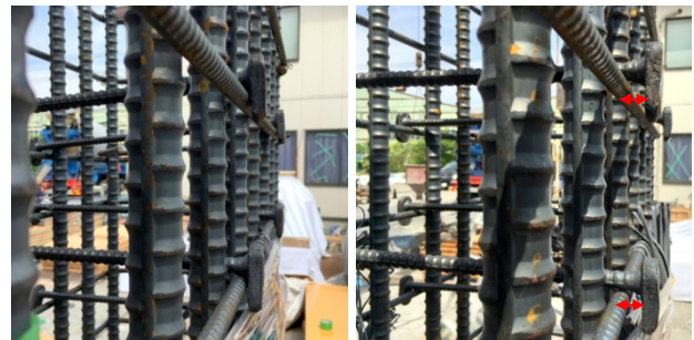
(a) P2 試験体
