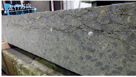
写真-2 切断面のひび割れ性状 (D-D, 試験終了後)
