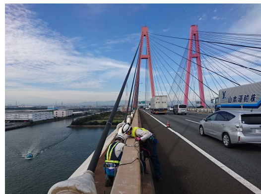
写真-1 実橋での高次振動法による張力測定状況
