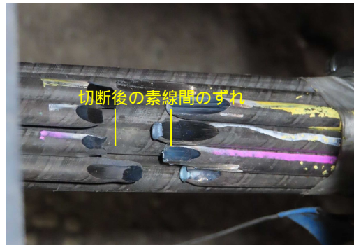
(2)グラウト無 4本切断時の状況
