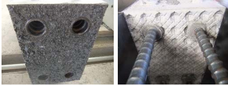
図-2 目粗しおよび打継ぎ界面の状況
