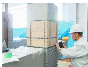
(e) タイル施工状況
