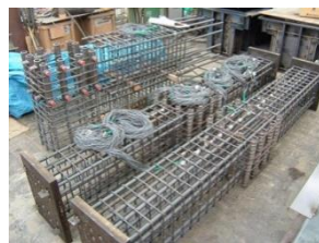
(b) 鉄筋組立状況
