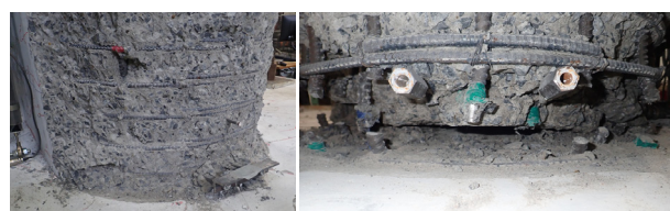
(a) 4 \delta_y3 サイクル目 (b) 6 \delta_y1 サイクル目 図-4 載荷面側基部の損傷状況 (No. 2)
