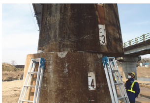
(a) 打継目のずれ
