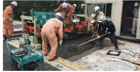
写真-4 施工実験状況
