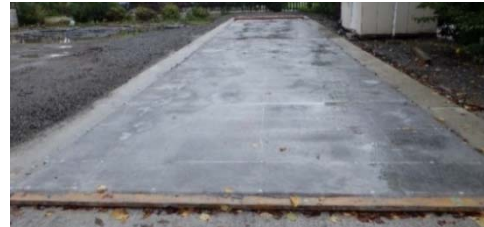
写真-5 施工後状況(シート養生後)
