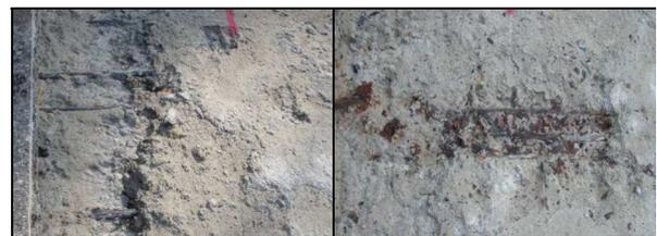
(1) 床版上面の土砂化 (2) 鉄筋の断面欠損
