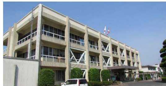
写真-1 対象建物外観
