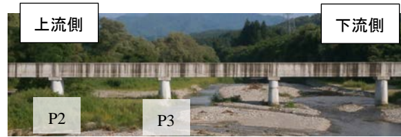
(a) コンクリート水路橋全景
