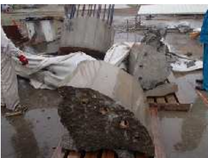
写真 - 27 破砕後の状況
