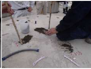
写真 - 16 詰め物（砂） タンピング
