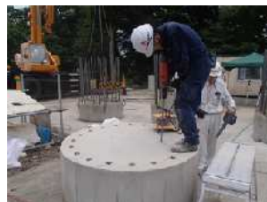
写真 - 13 装薬孔削孔
