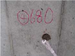
写真 - 9 込め物(砂)完了
