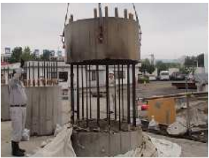
写真 - 19 破砕後揚重
