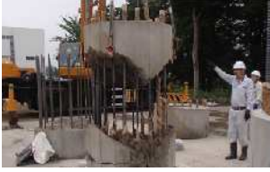
写真 - 23 破砕後揚重 ( 1,200,装薬孔:3本 )
