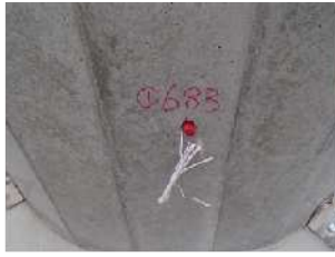
写真 - 7 装薬容器挿入
