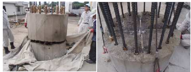
写真 - 21 破砕後揚重
