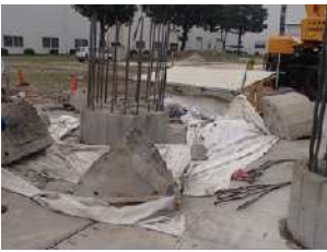
写真 - 25 破砕後の状況
