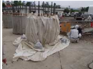
写真 - 10 防爆養生
