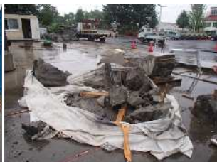
写真 - 28 破砕後の状況
