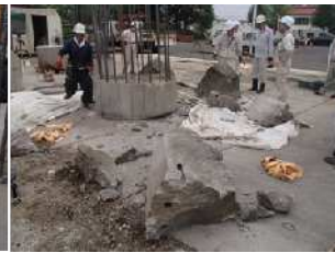
写真 - 26 破砕後の状況
