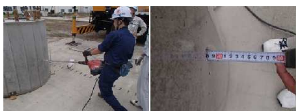
写真 - 5 装薬孔削孔
