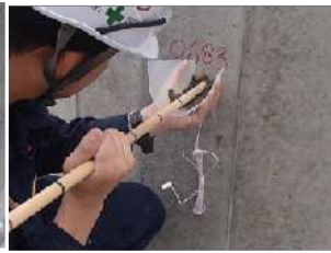
写真 - 8 込め物(砂)タンピング
