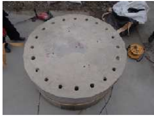
写真 - 15 装薬孔削孔完了
