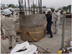
写真 - 17 吹き上がり防止
