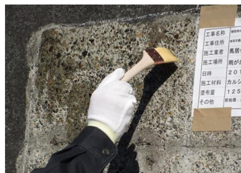
写真-2 含浸材の塗布
