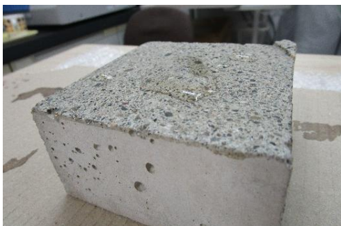
写真-3 撥水材を混入したけい酸塩系表面含浸材の塗布後の様子（水をはじいている）
