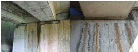
図-13 桁座打替え工法と樹脂注入工法の再変状
