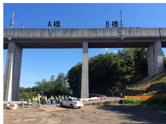
図-2 A 橋・B 橋 概況写真
