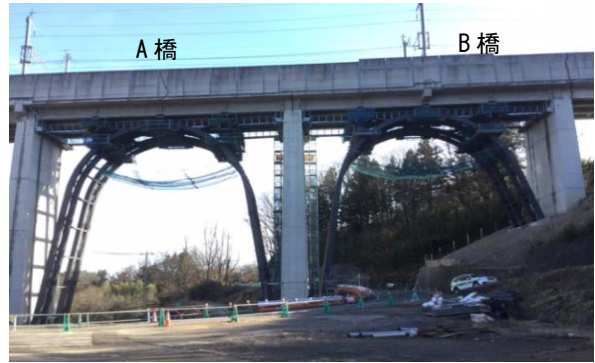
図-14 A橋, B橋 対策工完了写真
