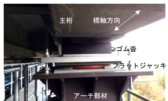
図-10 フラットジャッキ設置状況
