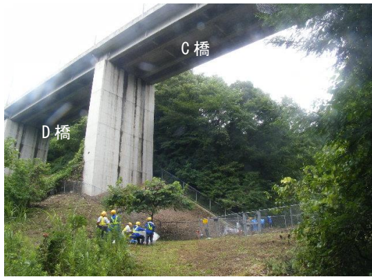
図-3 C橋・D橋 概況写真
