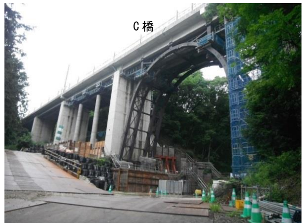
図-15 C橋 対策工完了写真
