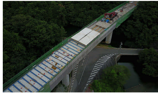
図-11 床版取替工事の状況
