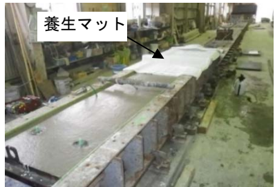
写真-1 打込み面の養生
