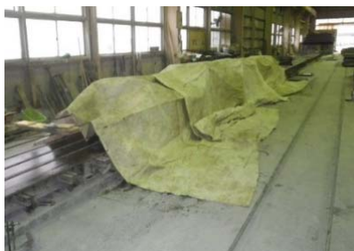
写真-2 蒸気養生状況
