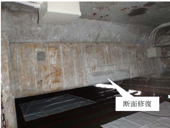
写真-1 対象構造物の状況(施工前)
