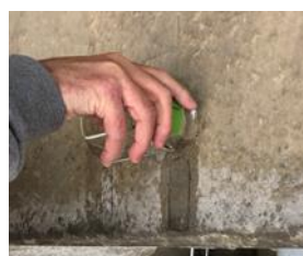
写真-8 洗い流し状況
