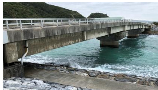
写真-4 対象橋梁全景
