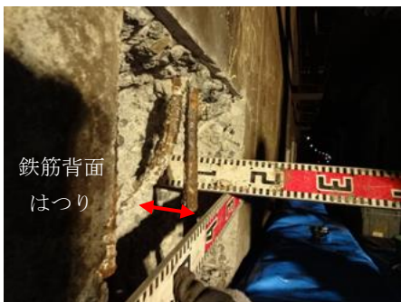
写真-5 鉄筋背面までのはつり状況
