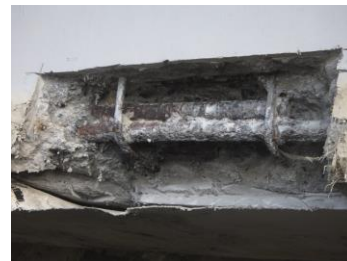
図-17 下り線鉄筋状態
