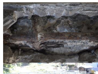
図-18 上り線鉄筋状態
