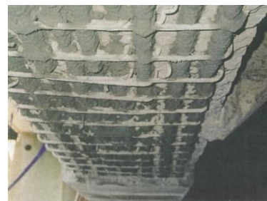
図-9 防錆材塗布後の状況
