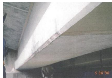
図-10 型枠脱型後の状況
