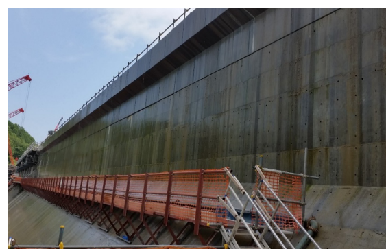
写真-11 打込み後の状況（下流左岸側より）
