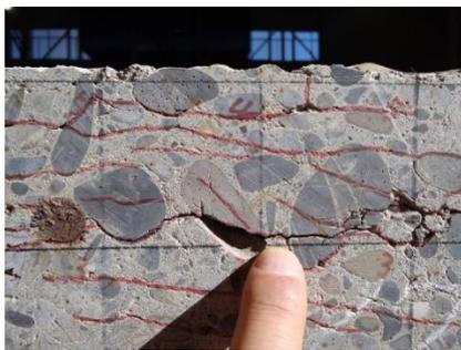
写真—5 撤去された床版の断面と水平ひび割れ
