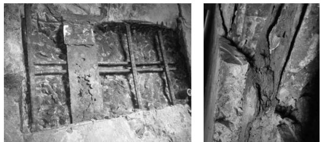
写真-1 腐食による断面欠損<sup>1)</sup>
