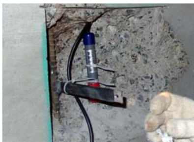
写真-1 照合電極の埋設
